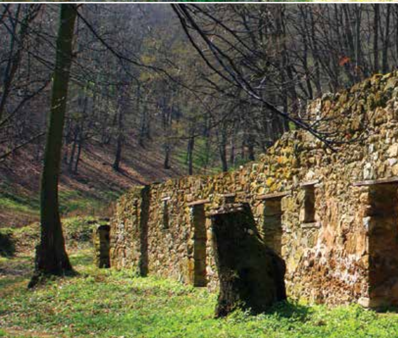
Поглед на конак са јужне стране
